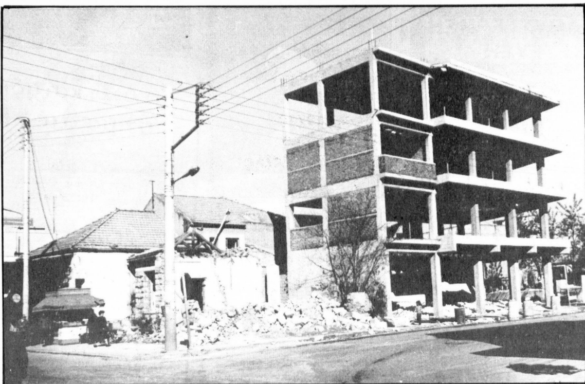
Ολοκληρώνεται ομαλά η κατεδάφιση του Δασαρχείου και του ακινήτου Παπαμελετίου παρά την ολιγοήμερη καθυστέρηση λόγω των απεργιών. Ήδη είναι έτοιμα τα σχέδια και αρχίζει η διαμόρφωση των οδών Ηρώων Πολυτεχνείου και Ελ. Βενιζέλου. Άλλη μια πολύχρονη προσπάθεια του Δήμου δικαιώνεται και ένας ακόμα κοινόχρηστος χώρος του Σχεδίου Πόλης αποδίδεται στο λαό της Ελευσίνας παρά τα εμπόδια και τις δυσκολίες που έπρεπε να ξεπεραστούν από πολλές πλευρές.
