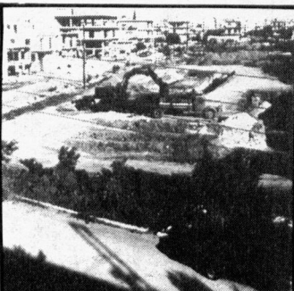
Άρχισαν τα έργα Ανέγερσης του 4ου Δημοτικού Σχολείου Ελευσίνας στα βόρεια του Νεκροταφείου. Το έργο ολοκληρώνεται στα τέλη του 1987 και θα καλύψει βασικές ανάγκες κτιριακές των μαθητών της Άνω Ελευσίνας.
